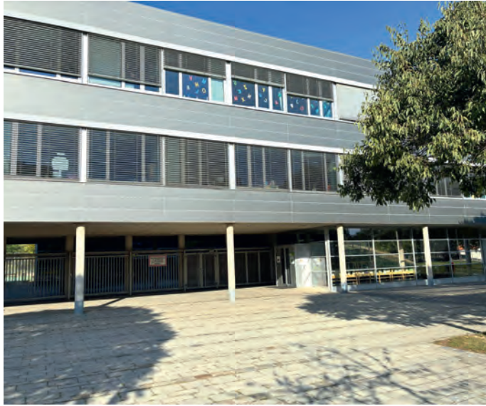
In der Volksschule Alma-Seidler-Weg werden Klassenräume saniert.
